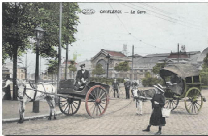
▲ Fig. 1 : Vue de la gare de Charleroi-Sud vers 1900. Elle fut station-perception de 1853 à 1863. Elle était desservie par les lignes de chemin de fer: Bruxelles - Namur et Erquelines - Liège où circulaient les ambulants Midi 5 - Midi 6 - Midi 3, puis Est 4 et Est 5.
